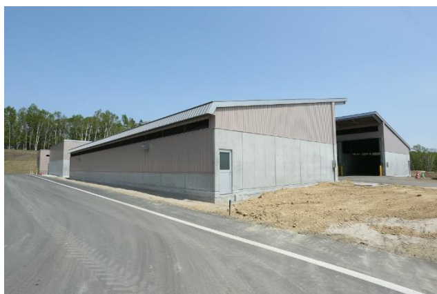
生ごみたい肥化施設
